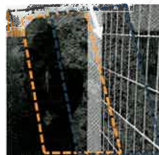
写真 B : 旧擁壁の上に被せて新設された北西側擁壁
