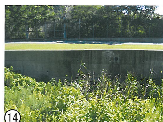
14 小川と道路側コンクリート擁壁
